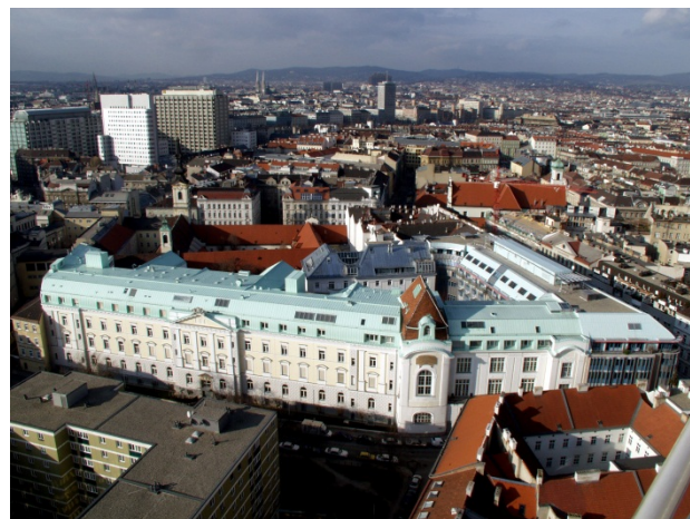
Foto: Krankenhaus der Barmherzigen Brüder Wien
